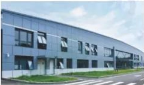
万国数据北京十一号数据中心
